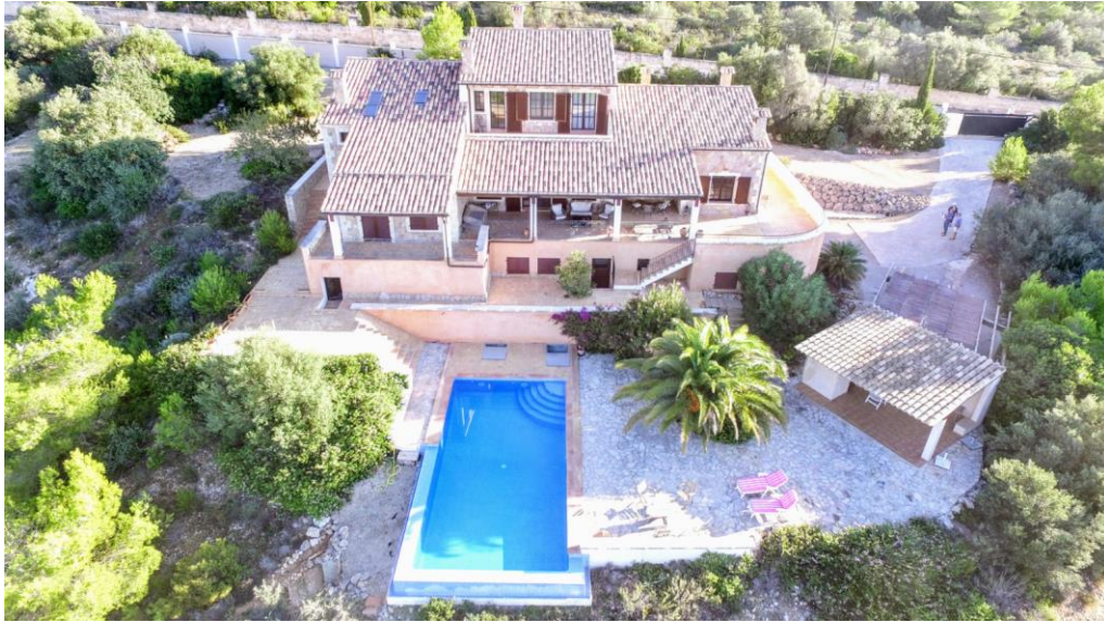
Blick auf das komplette Haus aus Süden
